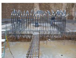
Un network di sensori di temperatura è stato posizionato in corrispondenza delle superfici di dissipazione e su alcuni tiranti in profondità nel terreno; la disponibilità delle temperature e dei loro gradienti consente al BMS l'attivazione di logiche di gestione ottimizzata della potenza dissipabile e delle possibili evoluzioni termiche del sistema di scambio.
