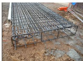
L'impianto geotermico è costituito da 12 Km di tubazioni distribuite nelle paratie perimetrali e sotto la platea di fondazione a contatto con il terreno, l'energia primaria viene prelevata dal sottosuolo con scambio diretto tra le tubazioni e il terreno senza l'utilizzo di gas. Un gruppo frigorifero a ciclo non reversibile, alimentato dall'impianto fotovoltaico, utilizza questa energia per produrre l'acqua calda in inverno e l'acqua refrigerata in estate.
